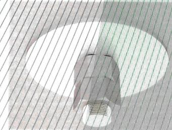
Bild 11: Versteifungsplatte mit zwei Sechskanmuttern
